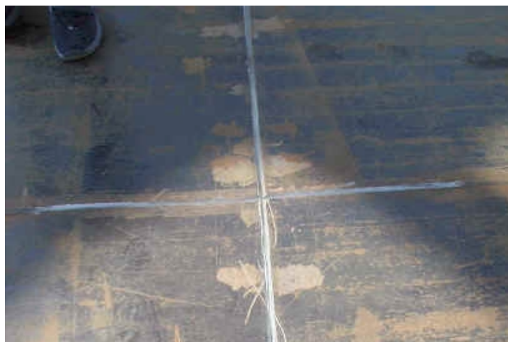
Slika 9.5 Fotografija zavarenih uzdužni i poprečni žljebova
