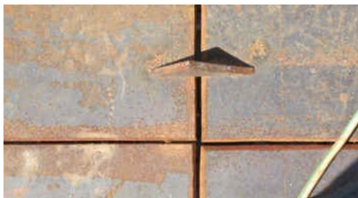
Slika 9.4 Fotografija uzdužni i poprečni žljebova
