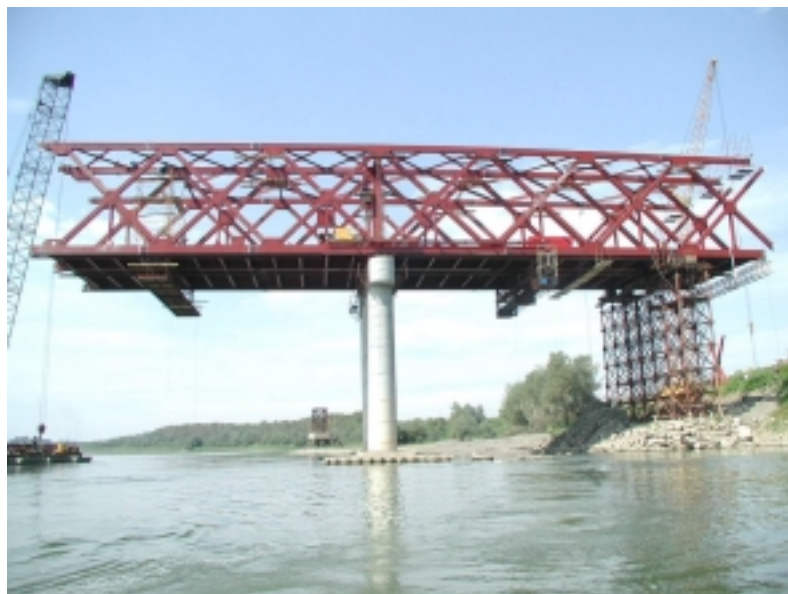
Slika 8.6 Fotografija dijela mosta
