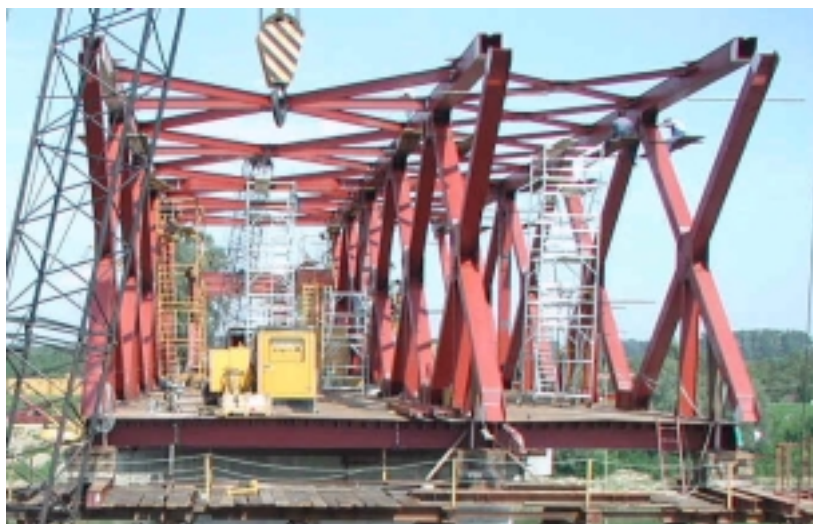
Slika 8.11 Fotografija mosta s prednje strane (ulaz na most)
