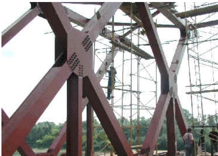
Slika 8.4 Fotografija "križa" na mosnoj konstrukciji
