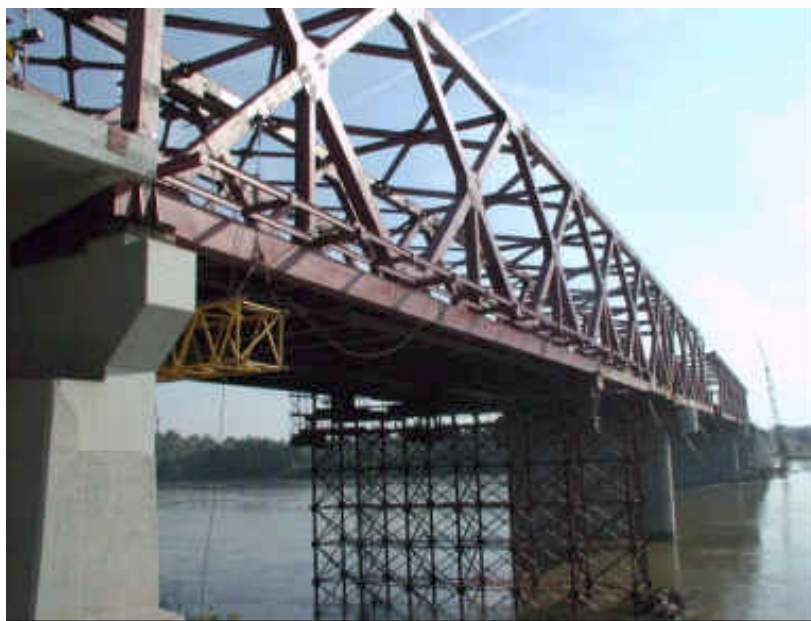
Slika 7.3 Fotografija dijela mosta u izgradnji
