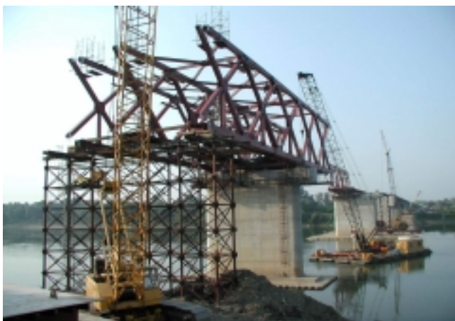
Slika 4.11 Postavljanje prvog segmenta mosne metalne konstrukcije preko rijeke Save u Slavenskom Šamcu
