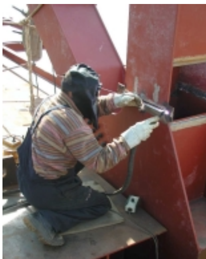
Slika 4.13 Fotografija TIG postupka zavarivanja
