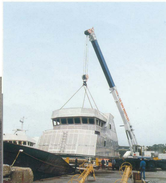
Slika 2.2.4 Spajanje aluminija i čelika pomoću trake te aluminijsko nadgrađe na čeličnoj konstrukciji broda izvedeno ovakvim trakama
