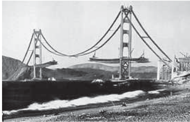
Slika 1.8.4 Golden Gate u izgradnji
